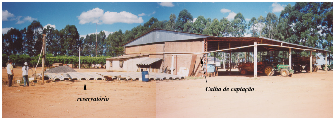
Figura 7.7 – Exemplo de sistema de captação e reservação de água da chuva para uso em aspersão de agrotóxico, Fazenda São Luiz.
