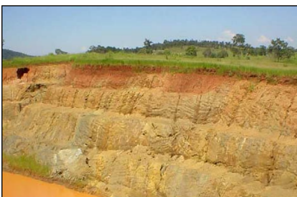
Figura 3.9 - Parede da cava em 2003, em que se nota o perfil de intemperismo e a gradação do solo para saprolito com Piroxenito hidrotermalizado alterado.
