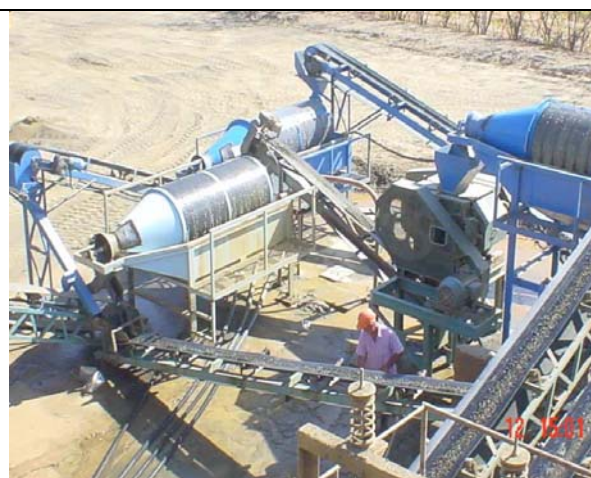
Figura 3.30 - Vista geral dos trommels classificatórios
