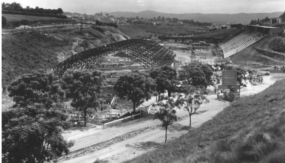
*Foto panorâmica mostrando o avanço das obras do estádio, identificando-se a estrutura da Cobertura do ginásio e a arquibancada lateral direita já assentada sobre o talude da grotá. Ao fundo, a Serra da Cantareira.*
