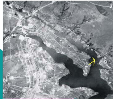
Fotografia aérea de 1965 mostrando parte da porção norte de Brasília e Lago Paranoá. A seta indica o local da foto ao lado
