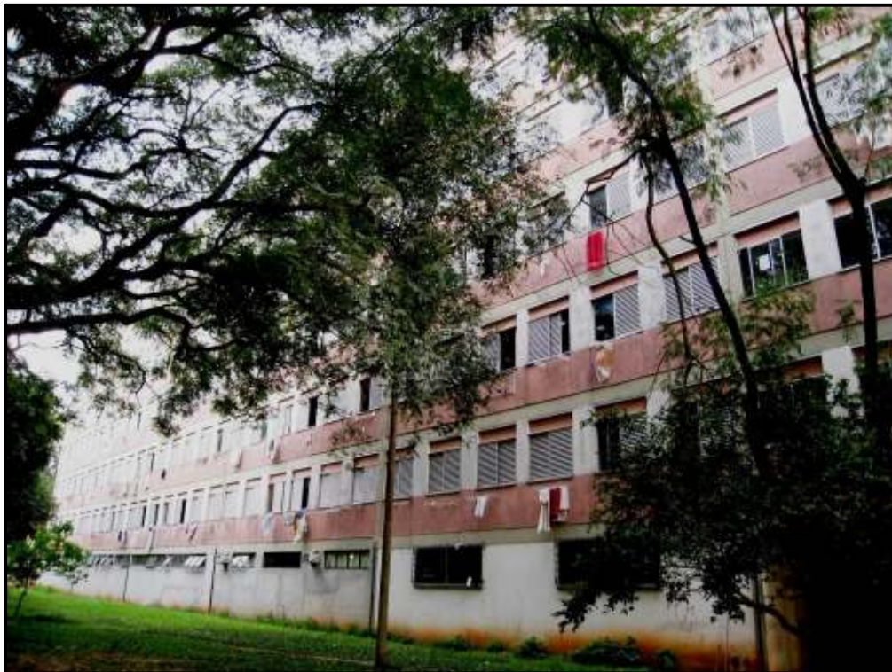
Térreos “obturados”. A sensação de amplidão de espaços foi eliminada (B)
