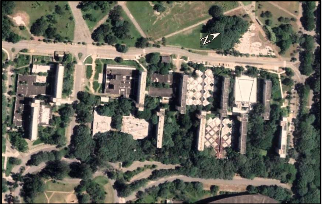
Imagem aérea atual do CRUSP. Notar a plena ocupação dos espaços entre-blocos por construções, todas alheias ao objetivo habitacional do CRUSP (imagem Google 2019)
