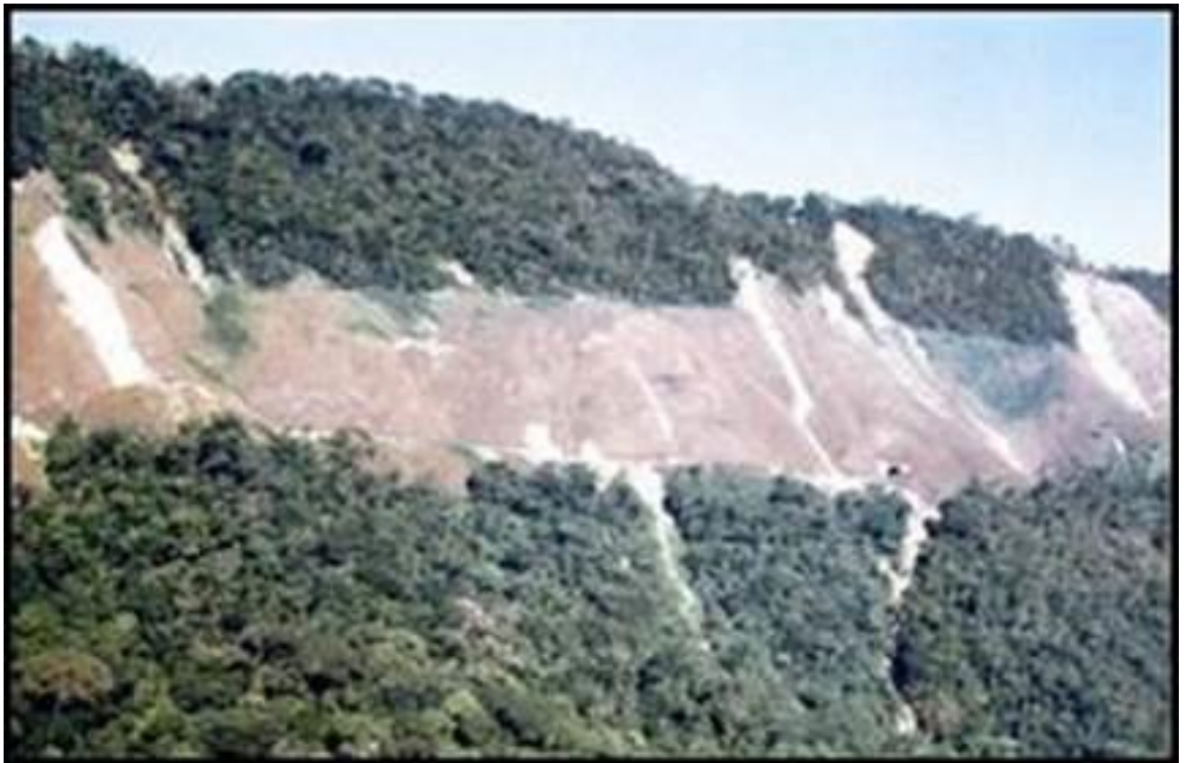
Fig.06 - Erro idêntico cometido pela engenharia brasileira no trecho Serra do Mar da Estrada de Ferro Sorocabana. Notar os inúmeros deslizamentos associados a esse desmatamento.
