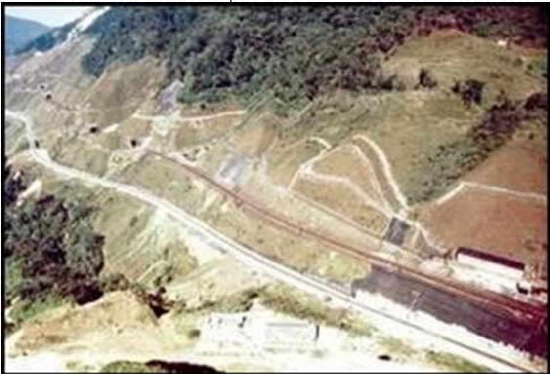
Fig. 05 - Enorme faixa desmatada a montante da ferrovia Santos Jundiaí na travessia da Serra do Mar. Erro grave cometido pelos ingleses ao imaginar que as árvores da floresta tropical poderiam potencializar deslizamentos. Ao contrário, foi esse desmatamento que induziu o enorme número de deslizamentos com que teve que conviver a ferrovia desde sua construção.
